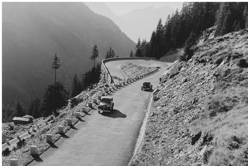
Abb. 6: Haarnadelkurve mit überhöhter, das heisst speziell für den motorisierten Verkehr geeigneter Fahrbahn (Sustenpass bei Feldmoos, 25. Oktober 1949).
