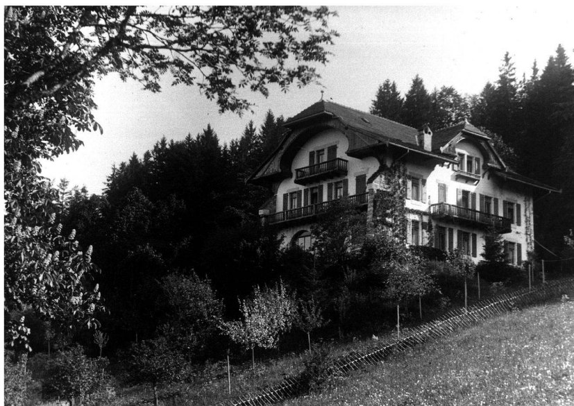
La Capucine, construite en 1905.
