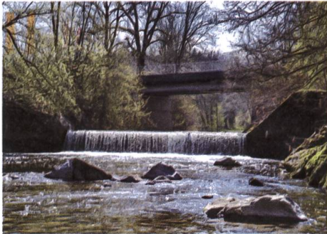
Eine Fischtreppe anstelle der alten Betonsperre in der Glatt.
