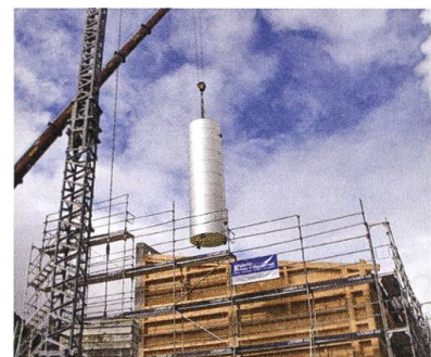
Der Wärmespeicher wird an seinen Platz gehievt.
