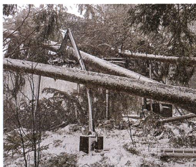
Ein Bild der Zerstörung beim Skilift Oberdorf.
