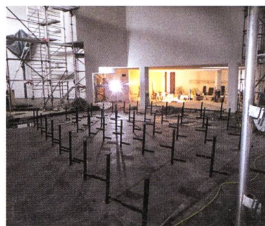
Innenraum der katholischen Kirche im Bauzustand.
