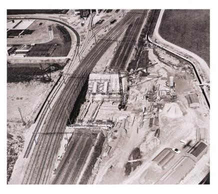
Der Bau der vierspurigen Eisenbahnbrücke über den Einschnitt für die Nationalstrasse N 1 bei Wil erforderte im EXPO-Jahr 1964 eine Umfahrung der Baustelle. Zwei Spuren dienen der Hauptlinie Richtung St. Gallen, eine Spur führt Richtung Wattwil, und die vierte Spur dient als Industriegeleise. Bildarchiv ETHZ.
