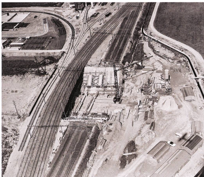
Der Bau der vierspurigen Eisenbahnbrücke über den Einschnitt für die Nationalstrasse N 1 bei Wil erforderte im EXPO-Jahr 1964 eine Umfahrung der Baustelle. Zwei Spuren dienen der Hauptlinie Richtung St. Gallen, eine Spur führt Richtung Wattwil, und die vierte Spur dient als Industriegeleise. Bildarchiv ETHZ.
