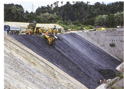
Die Böschung der Deponie wird geteert.
