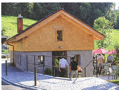
Das neue Waschhaus, das keines mehr ist.
