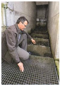
Wasserkraftwerk bei der Stadtbrücke in Lichtensteig. Links im Bild erkennt man die mit einem stabilen Gitterrost überdeckte Fischtreppe. Dank ihrem reduzierten Gefälle und der speziellen Sohlenstruktur dient sie den Fischen als Aufstiegshilfe zur Überwindung der Wehrpassage.
