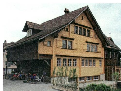
Die neue Fassade des Ortsmuseums.
