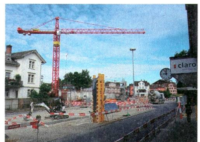
Die Baustelle am Bahnhofplatz.
