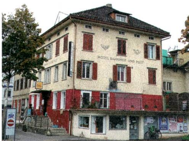
Das alte Hotel Bahnhof und Post wird abgebrochen.
