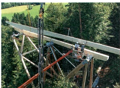
Luftiges Aufrichten des Tragwerks für den Baumwipfelpfad.
