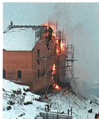
Die eingerüstete Zwinglipasshütte brennt lichterloh.
