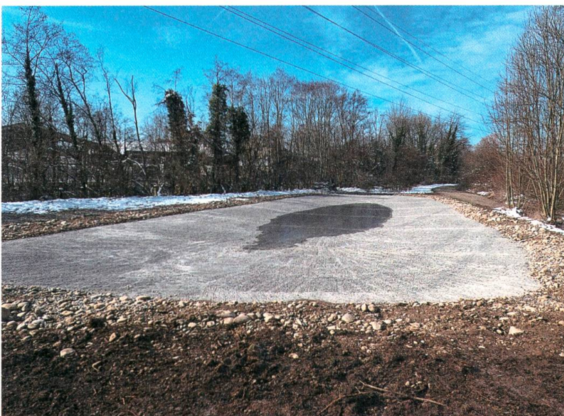
An der Thur bei Uzwil, wo bis vor 50 Jahren die letzten Kreuzkröten lebten, wurde ein Betonteich als Nachbildung eines Auentümpels angelegt. Dieser Teich eignet sich speziell für die Kreuzkröte. Damit soll diese sehr seltene Art, die in der Region nur noch an zwei Orten überlebt hat, wieder an der Thur heimisch werden. Foto: J. Barandun.
