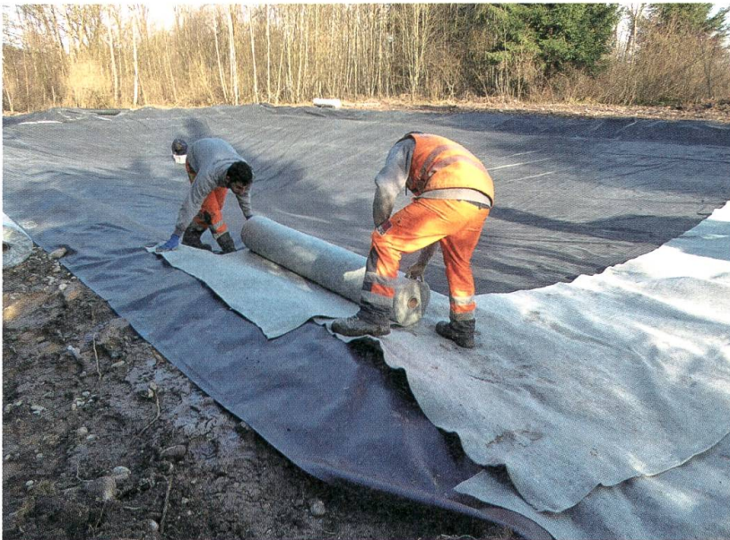
Weil sich das Grundwasser entlang der Thur abgesenkt hat, musste zur Wiederherstellung eines Amphibienlaichgewässers in der ehemaligen Aue eine Teichfolie verlegt werden. Foto: J. Barandun.
