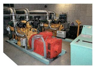
Strom. Das entspricht etwa dem Durchschnittsverbrauch von 214 Einfamilienhäusern. Auf der Schwägalp stehen zwei Diesel-Notstromaggregate. Mit dem einen, es weist eine Leistung von 400 kVA auf, wird der Schwebebahnbetrieb bei Stromunterbruch gewährleistet. Mit dem zweiten Notstromaggregat, welches eine Leistung von 200 kVA aufweist, wird sichergestellt, dass die restliche Infrastruktur auf der Schwägalp für den Notfall mit Strom versorgt werden kann.
