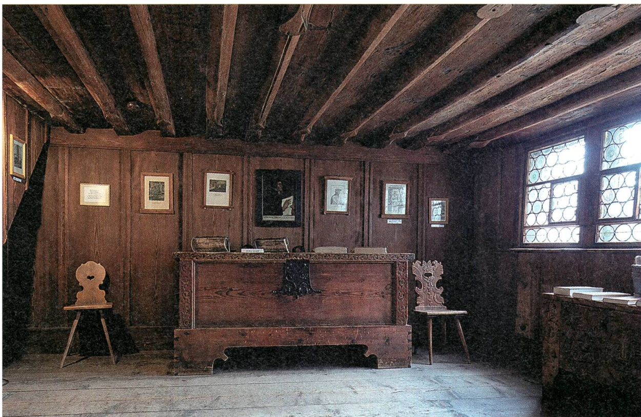
Blick in die Stube mit der gotischen Bohlen-Balken-Decke. Foto: Hans Büchler, Wattwil.
