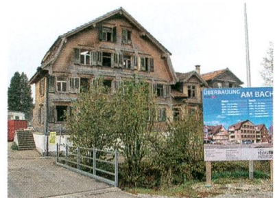
Die Liegenschaft Wenk vor dem Abbruch.
