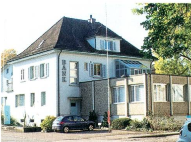
Das jetzige Bankgebäude wird abgerissen.
