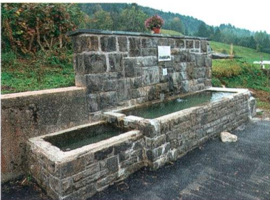
Der sanierte Brunnen beim Kurhaus Rietbad.
