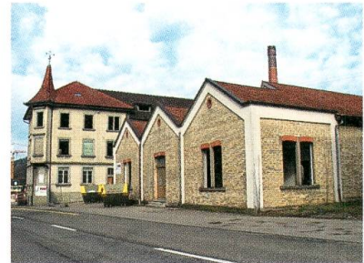
Das markante Eckgebäude muss der Umfahrungsstrasse weichen.
