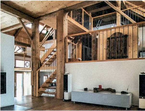
Innenraum eines in der Hülle einer Scheune gebauten Wohnhauses. Das räumliche Potenzial wurde beispielhaft ausgeschöpft. Konstruktive Elemente des Vorgängergebäudes wurden integriert.
