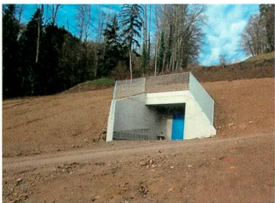
Das neue Wasserreservoir oberhalb von Metzwil.
