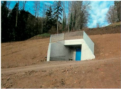
Das neue Wasserreservoir oberhalb von Metzwil.
