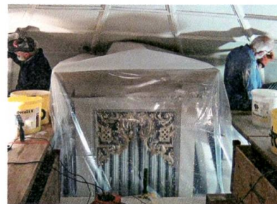
Die Renovationsarbeiten im Krinauer Kirchenhimmel.
