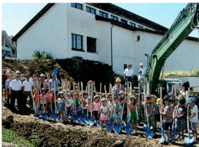
Die Kindergärtler dürfen den Spatenstich für einen neuen Kindergarten durchführen.
