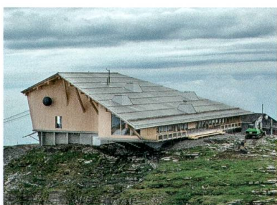
Das neue Gipfelrestaurant auf dem Chäserrugg.
