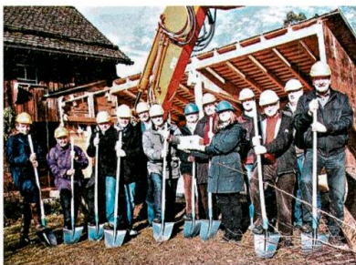
Spatenstich beim Ackerhus.
