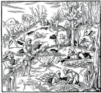
Oben links: Arbeit am sogenannten Herd, hier einer hölzernen Aufbereitungsanlage (A, B, C): gut sichtbar der Wasserzufluss (I), die Rillen (E) und die Schaufel (G).
