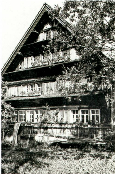
Oben: Haus an der Gasse (Gottahaus).
