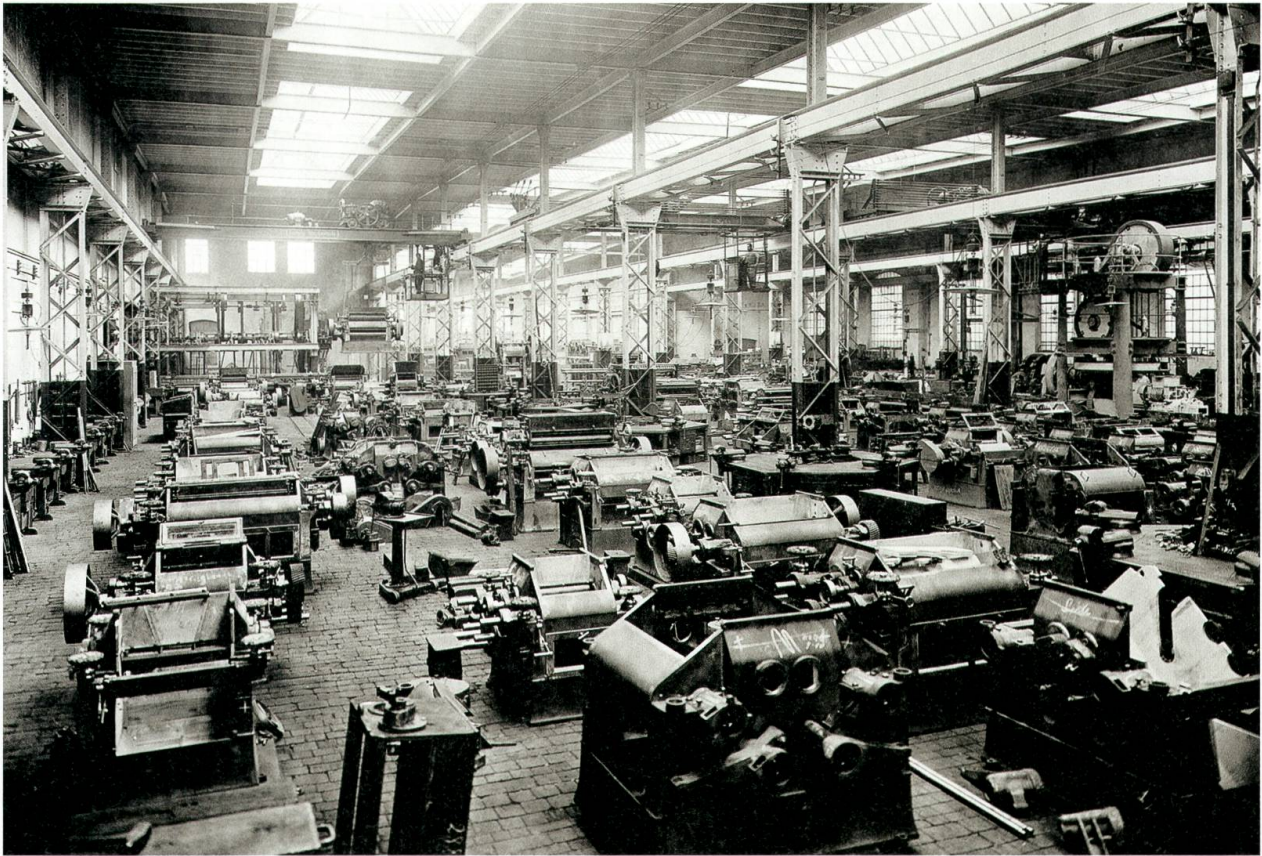
Montagehalle 1914: Walzenstühle, wo man hinschaut.
