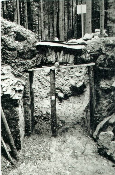
Blick vom Kellerraum ins Freie: Torbogen des Westausgangs, September 1946.
