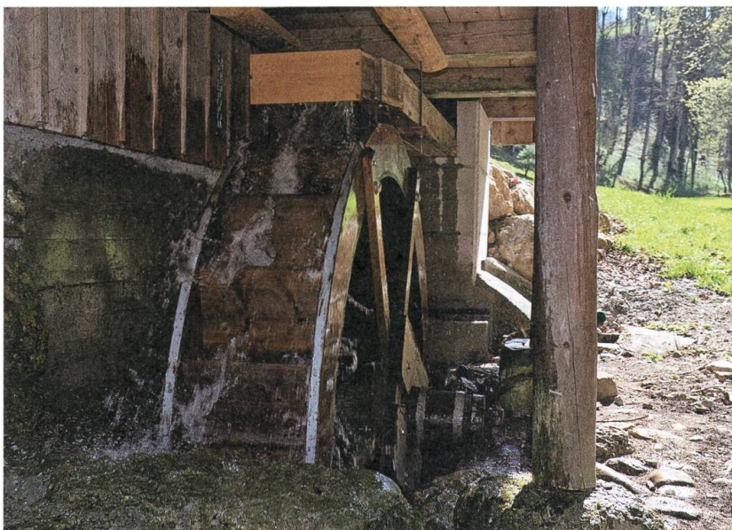
Das oberschlächtige Wasserrad der Beistampfi.
