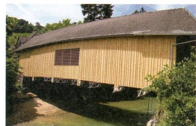
Die renovierte Tös-Brücke über den Necker.
