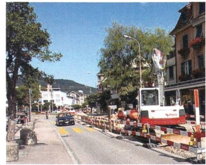
Die Baustelle Bahnhofstrasse macht eine Umleitung nötig.
