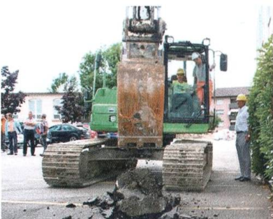
Spatenstich bei der Morga.
