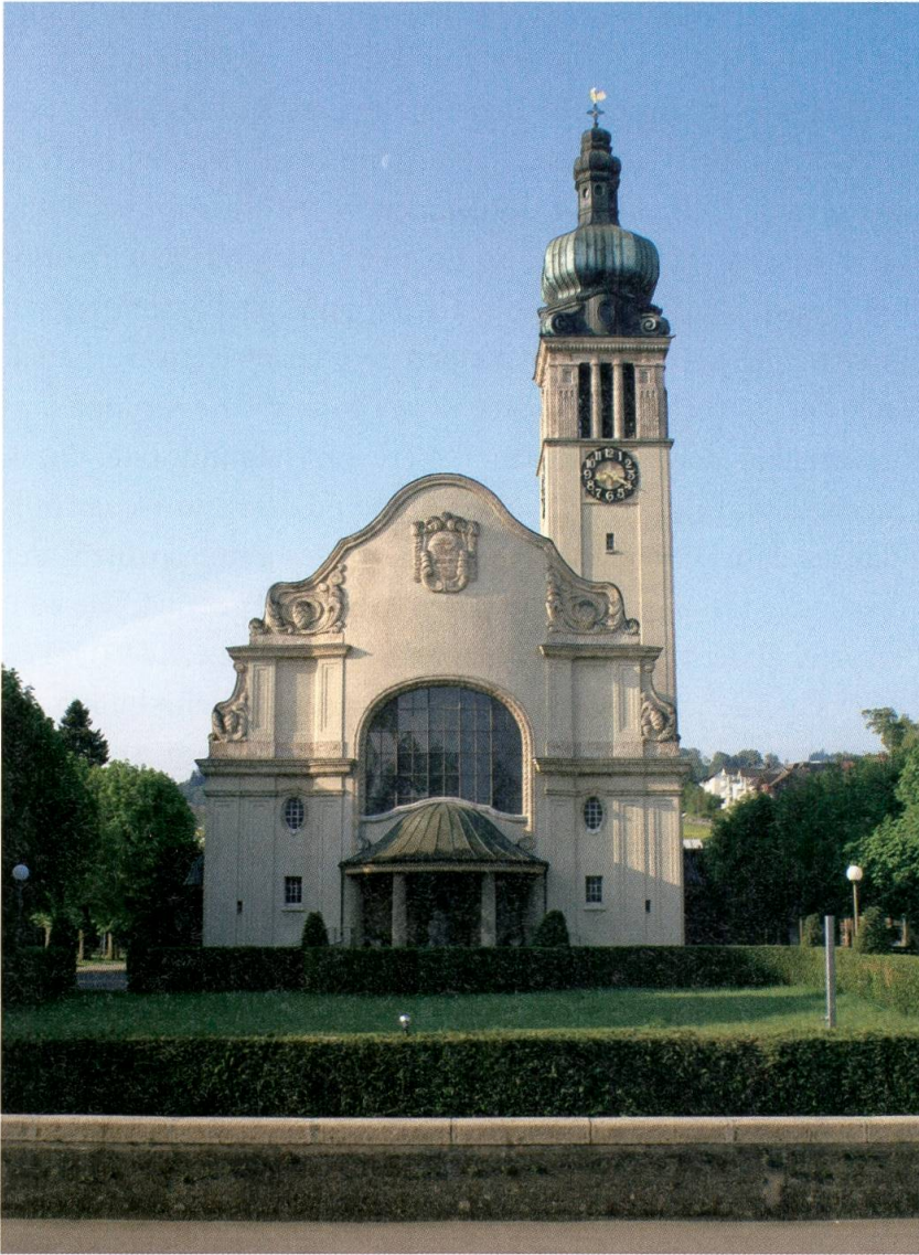
Nordansicht der evangelisch-reformierten Kirche Flawil. Foto: A. Heer.
