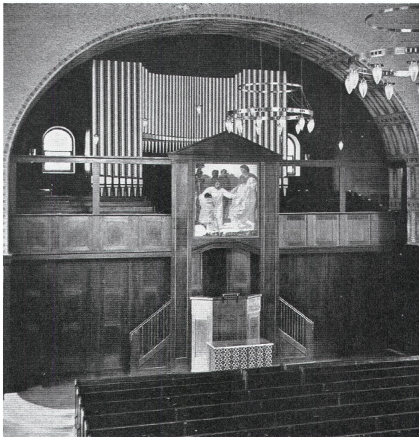
Sicht auf die ehemalige Kanzelwand, Kirche Degersheim. Foto: Bader 1908.
