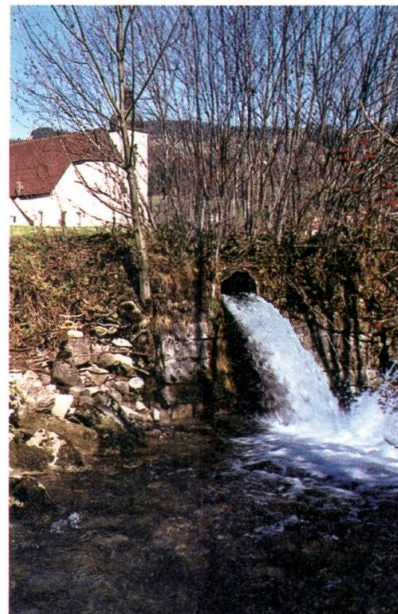
Nach Aufgabe der Ausäge musste ein direkter Unterwasser-Einlauf in die Lutern gebaut werden.
