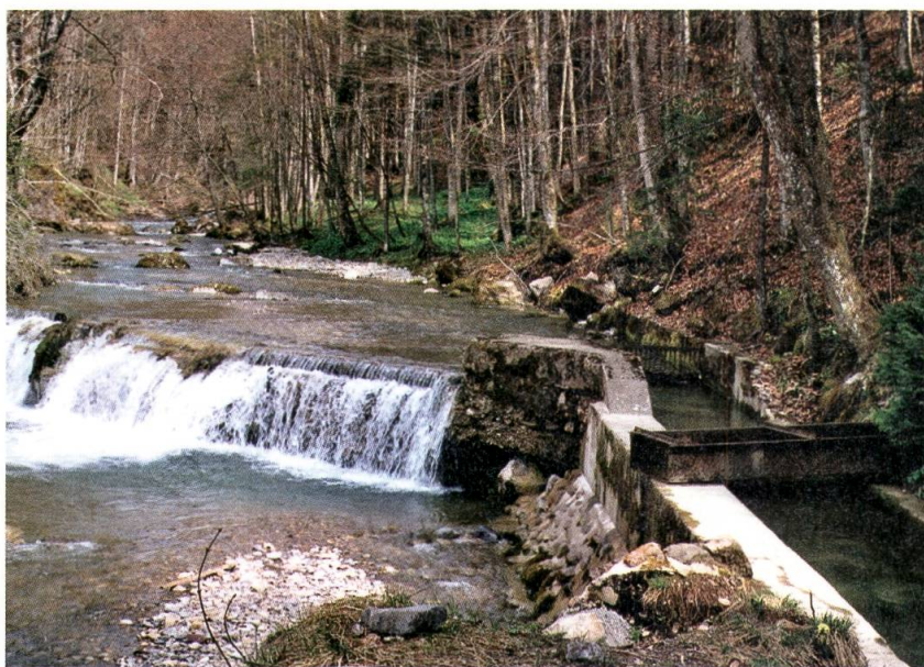
Wehr und Wasserfassung Gillsäge mit Oberwasserkanal.
