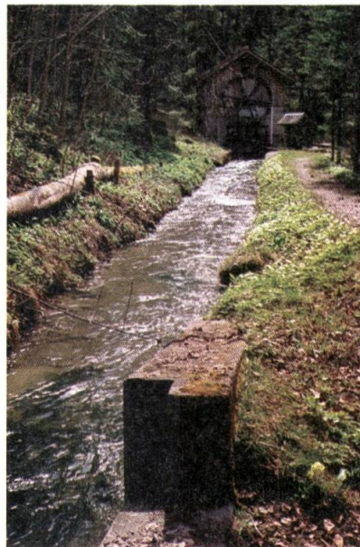
Oberwasserkanal Gillsäge in Flussrichtung mit Turbinenhaus.
