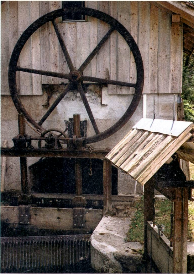
Bild oben links: Turbinenhaus mit Einlaufrechen sowie Einlauf- und Überlaufwehr. Darüber ein Seiltransmissionsrad.
