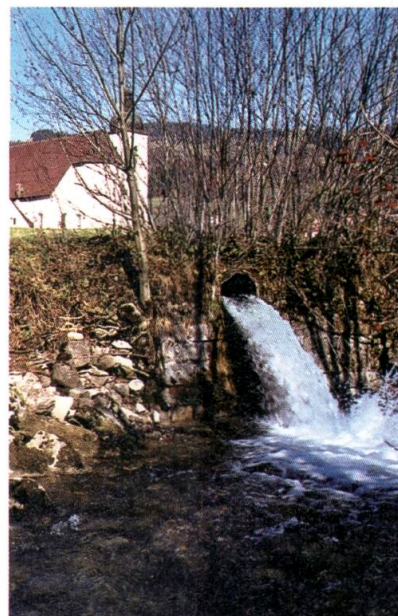
Nach Aufgabe der Ausäse musste ein direkter Unterwasser-Einlauf in die Lutern gebaut werden.
