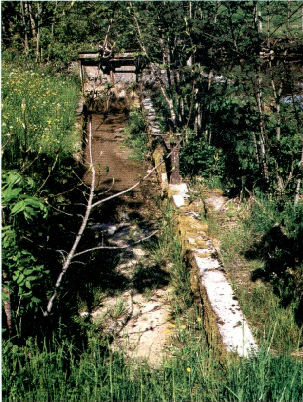
Bild links: Wehr und Einlaufbauwerk Herrenmühle mit Oberwasserkanal und Überlauffalle. Bild rechts: Herrenmühle mit dem westlichen Teil, in dem sich früher die Mühlenanlage mit separatem Wasserrad befand. In der Mitte der Auslauf des Unterwassers in den Oberwasserkanal der Anlage Meyer-Mayor. Letzterer und der einstigen Ausäße dient auch das Wehr mit Einlaufbauwerk, damit diese auch betrieben werden können, wenn die Herrenmühle ausser Funktion ist.
