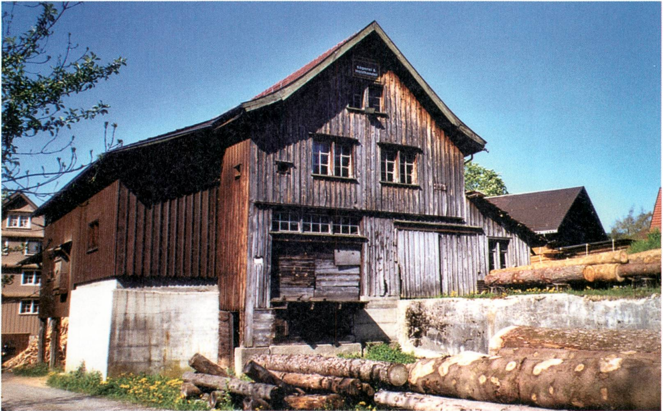
Die Sägerei der Herrenmühle von Osten mit dem Turbinenbau links, in der Bildmitte die Tore für die Rundholzzufuhr.
