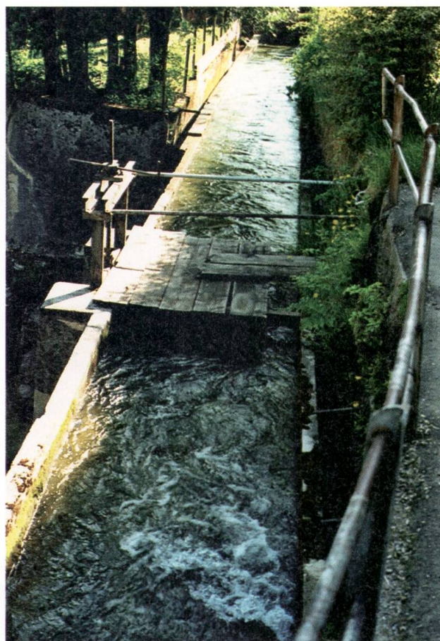
Bild links: Wehr im Bereich der Herrenmühle mit Einlaufbauwerk zum Oberwasserkanal der Fabrik Meyer-Mayor. Das Unterwasser der Herrenmühle wird in diesen Oberwasserkanal eingeleitet. Bild rechts: Oberwasserkanal mit Überlaufschieber.
