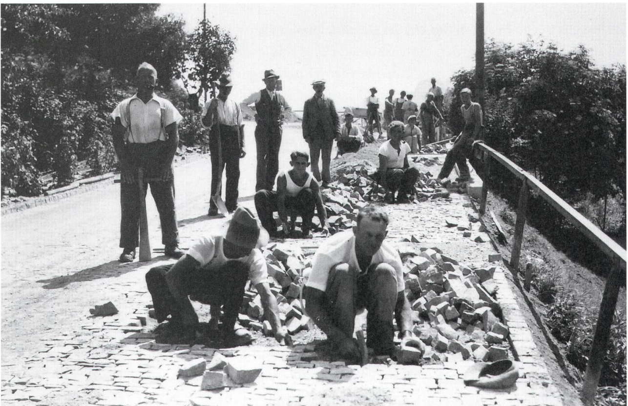
Pflasterung des Schützenhaus-Ranks auf der Wasserfluhstrasse um 1930. Foto: Toggenburger Museum Lichtensteig.
