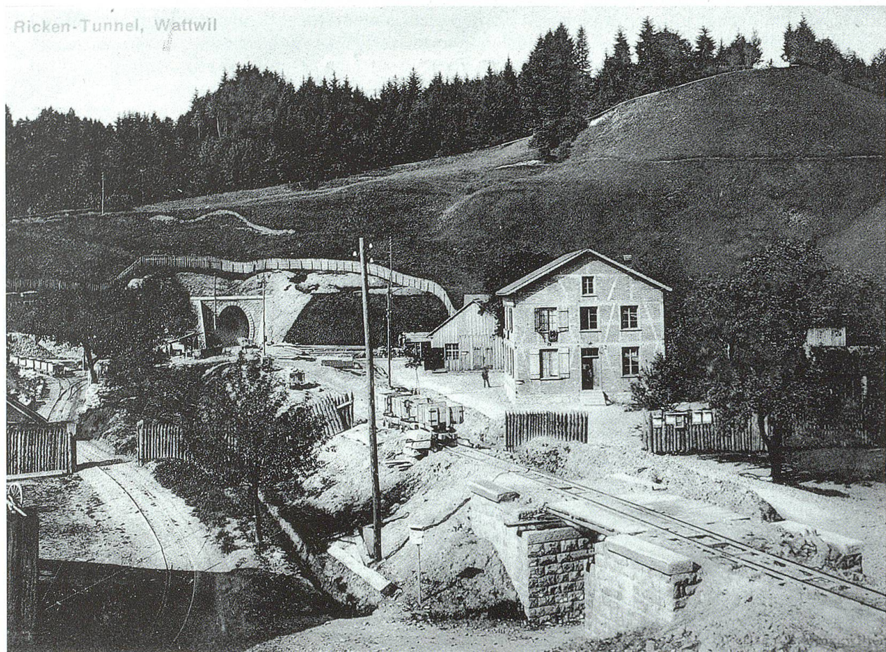
Sicht auf den Installationsplatz im Portalbereich bei Wattwil. Foto: Sammlung TML.
