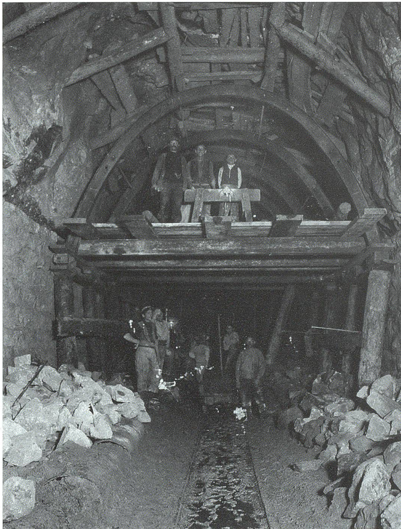
Gewölbebau im Rickentunnel. Foto: Sammlung TML.
