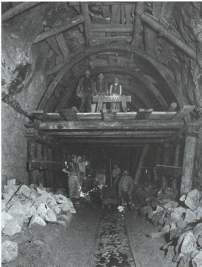
Gewölbebau im Rickentunnel. Foto: Sammlung TML.
