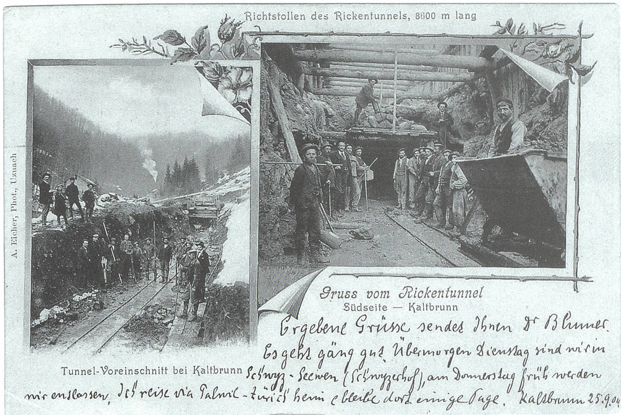
Der Tunnelbau in einer frühen Phase, Ende 1903, Anfang 1904. Foto: Sammlung A. Heer.
