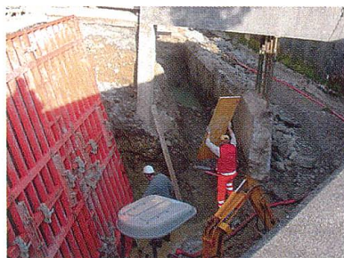
Bauarbeiten des Hochwasserschutzprojekts.
