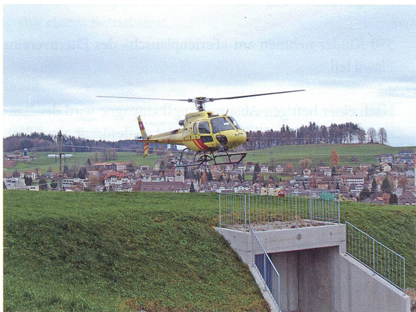
Verlegung der Hochspannungsleitung Fuchsacker.
