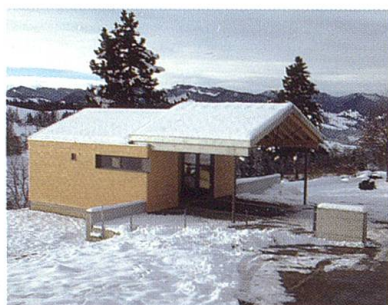
Die neue Abdankungshalle.
