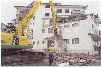
Abbruch des «Mühlehofs».
