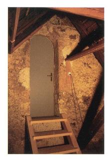
Blick vom Schiffestrich auf das Schallfenster des Turms von 1423, mit neuer Brandschutztüre. Deutlich erkennbar das saubere Gewände aus Kalktuff. Das Schallfenster mass ursprünglich 180 mal 67 Zentimeter (heute 210 mal 67 Zentimeter). Das Anschlussdach zum Schiff stammt von 1834, unter Verwendung von Sparren des spätgotischen Dachs. Foto: KA SG.
