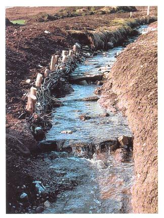
Dieses früher eingedolte Wiesenbächlein bei Wolfikon ist geöffnet und durch ingenieurbiologische Massnahmen (einfache Steinschwellen und Weidenfaschinen zur Sohlen- und Ufersicherung) revitalisiert worden. Die Bilder zeigen die frisch geflochtenen Weidenfaschinen im April 1996 und ...
