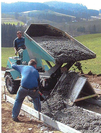
Befestigung eines steilen Bewirtschaftungsweges mit Betonspuren (Wittwil, 2005).
