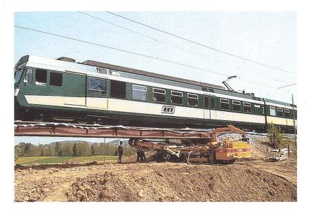
Bau der SBB-Unterführung Äspis der verlegten Austrasse. Der Zug fährt über die eingebaute Hilfsbrücke, während die Baumaschinen darunter den Aushub für die neue Unterführung vornehmen (1993).
