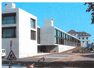
Das neue Wohn- und Pflegeheim wird nach zweijähriger Bauzeit eingeweiht.
