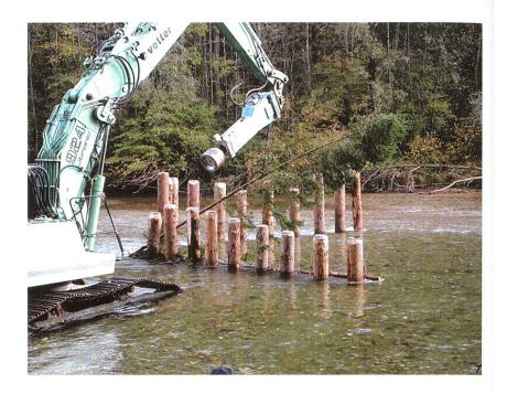
Oktober 2004, Bau des Flussteilers (Fliessrichtung der Thur von rechts nach links). Die Zwischenräume der gerammten Baumpfähle werden mit Nadelholzwipfeln gefüllt (Abb. 12).
