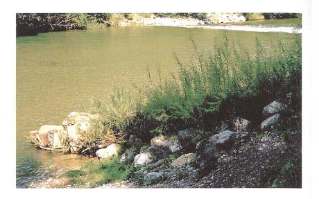
Buhne als Ufersicherung und zur Lenkung der Strömung, Bereich Sportplatz Niederstetten (Abb. 11).
