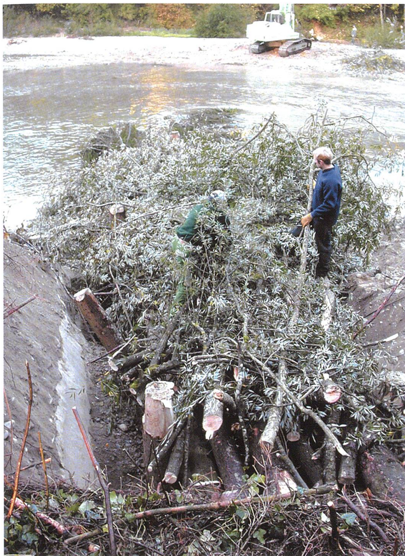
Bau einer Baumbühne als Uferschutz an der Interventionslinie Seite Niederstetten. Über das Baumbündel werden Weidenäste gelegt und in der Böschung mit Erdmaterial überdeckt, Oktober 2005 (Abb. 16).
