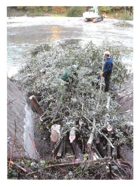
Bau einer Baumbuhne als Uferschutz an der Interventionslinie Seite Niederstetten. Über das Baumbündel werden Weidenäste gelegt und in der Böschung mit Erdmaterial überdeckt, Oktober 2005 (Abb. 16).
