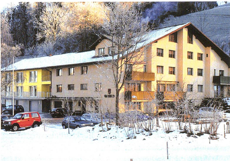
Das erweiterte und umgebaute Alters- und Pflegeheim Hofwis, Mosnang.
