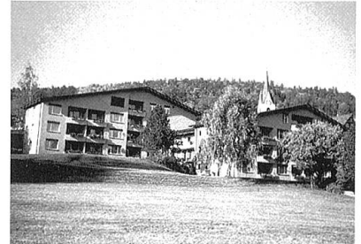
Alterssiedlung an der Austrasse.
