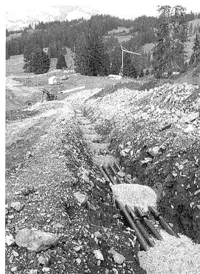
Wildhaus: 1,5 Kilometer Leitungsgräben mit über 10 Kilometer Leitungen.
