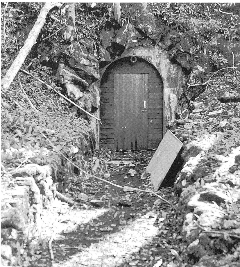
Eingang «Starkenbach Nord». Vorgehängte Holzartntüre, darüber Auspuffstutzen. Seitwärts, liegend, die schon demontierte Gasschleuse. Aufnahme Mai 1999.
