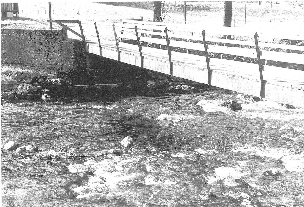
Ende der Tankmauer bei der Thur. Fortsetzung in der als Hindernis absenkbaren Stahlbrücke. Aufnahme November 2002.
