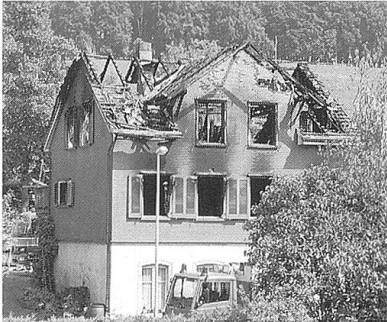
Das ausgebrannte Haus Fritschi.
