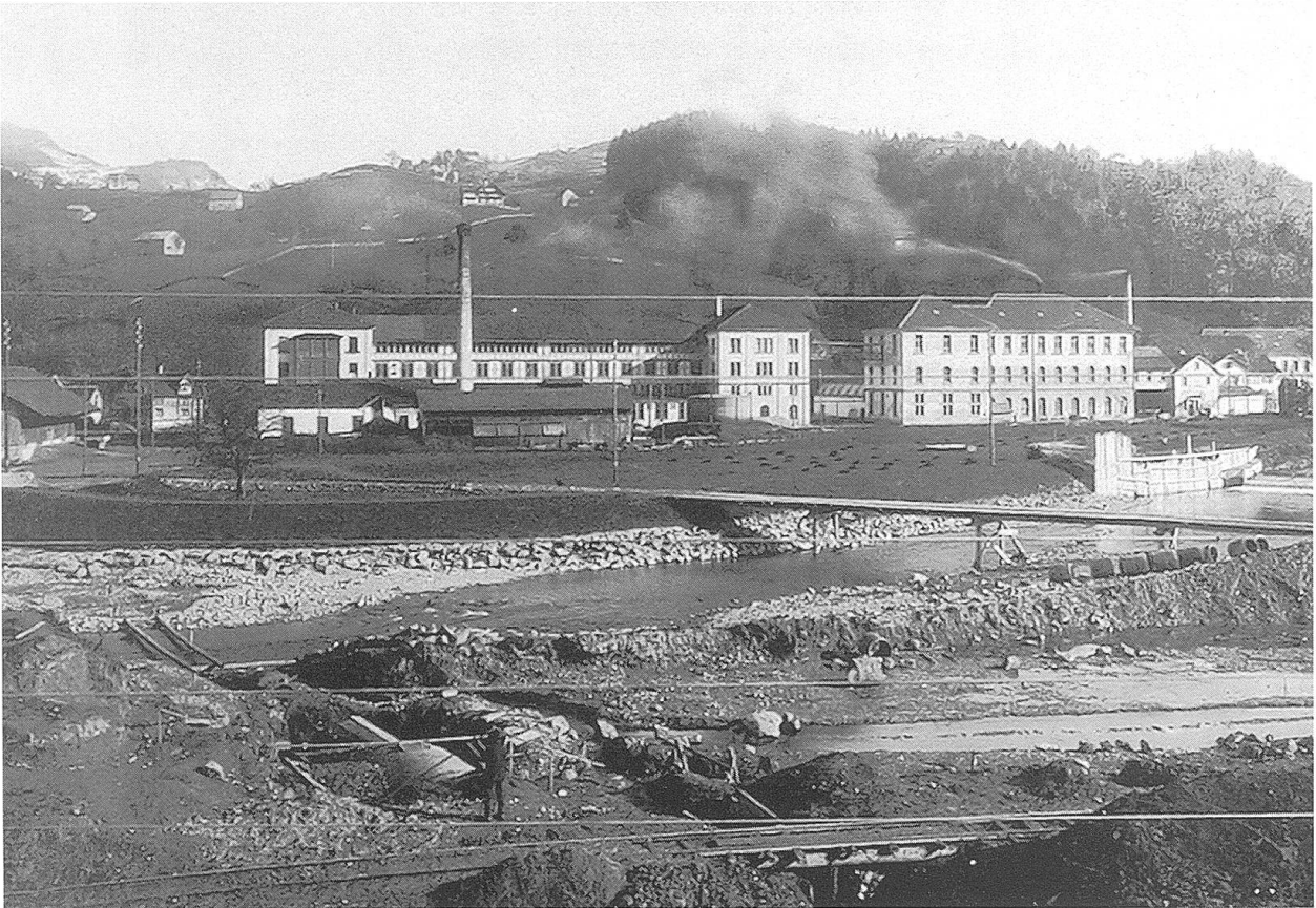
Rietwisbrücke während des Baus.
