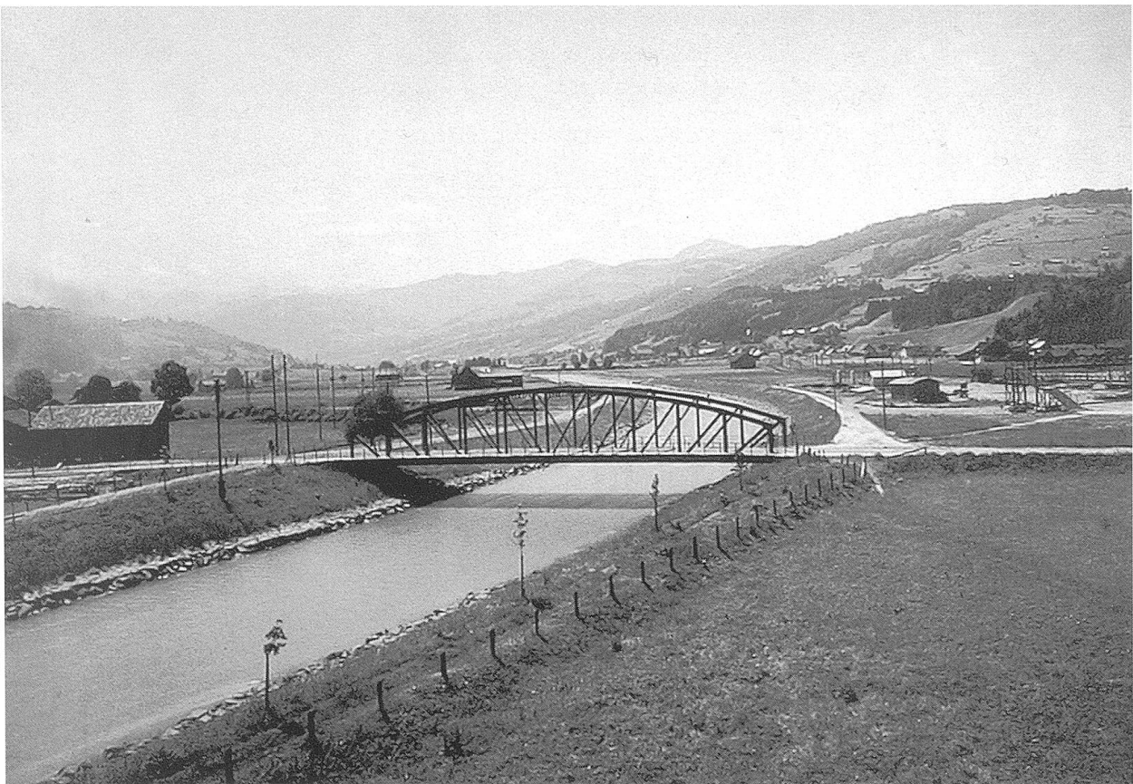
Thurbrücke bei Ulisbach nach dem Bau.
