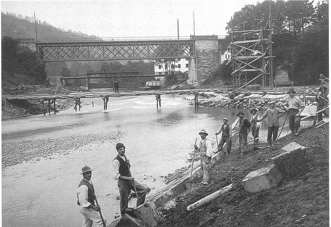
Korrektionsarbeiten oberhalb des Lichtensteiger Wehrs.
