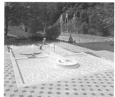
Erneueres Schwimmbad Lichtensteig.
