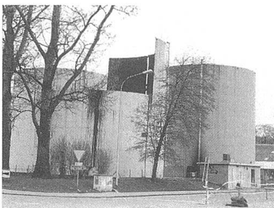
Firma Heberlein Textildruck: Abbruch von Tankanlagen und Stapelbecken.
