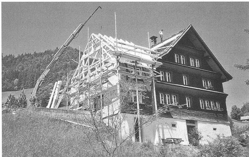
Anbau Pfarrhaus-Quergiebel für Sonnenkollektoren.
