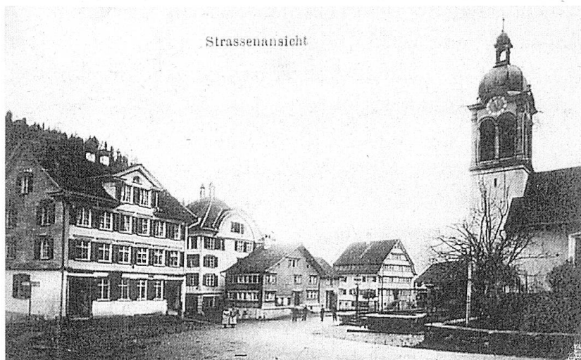
Die neue Strassenführung durch den alten Friedhof von St. Peterzell. Photo vom April 1907.
