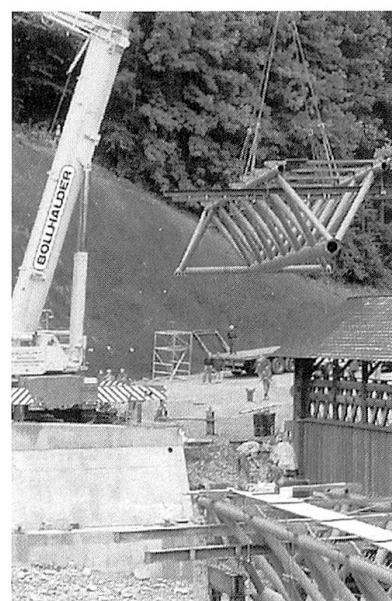
Einbau der Stahlträger.
