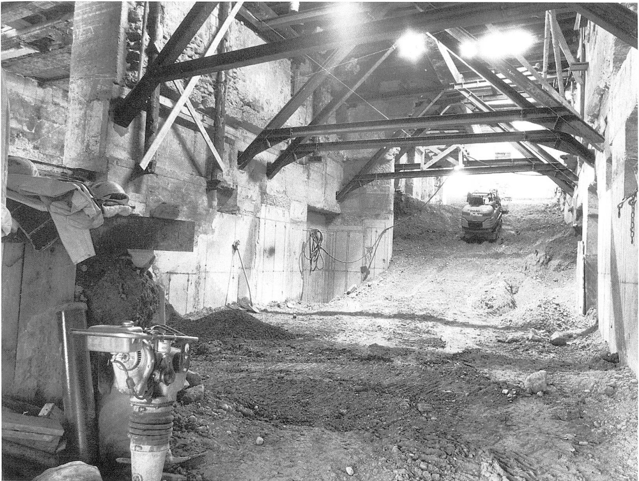
Maschinelles Aushub unter abgetragener Balkendecke der neuen Wirtschaft zum Hof.
