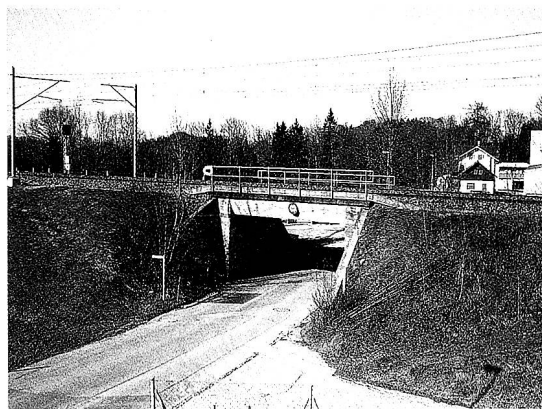
Die Strassenunterführung heute – Landschaft im Wandel.
