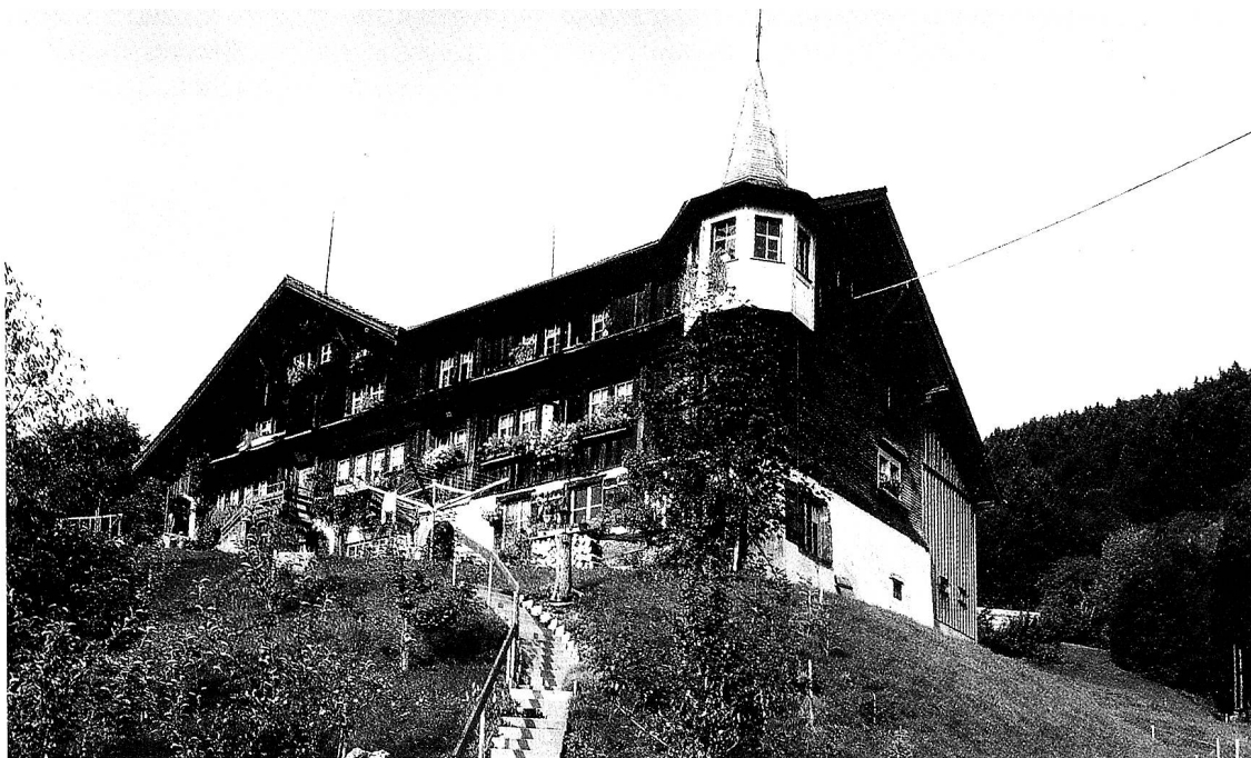
Das Türmlibaus im Mösli, Gesamtansicht von Osten. Der weit auskragende Turmerker schwebt hoch in der Luft. Deutliche Zweiteiligkeit des Wohnhauses, bestehend aus einem giebelständigen, oberen, südlichen Teil und einem in gleicher Vorderflucht stehenden traufständigen, unteren, nördlichen Teil.
