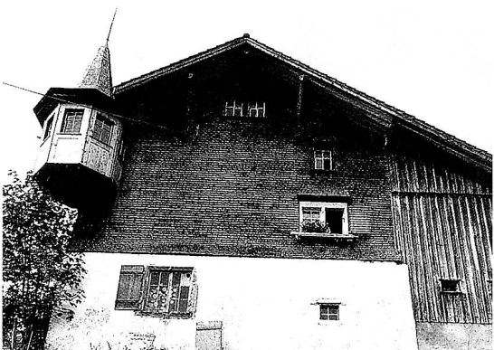
Nordostfassade mit Schindelschirm, anschliessend die verbretterte Stirnseite des angebauten Schopfs. Hinter dem Schindelschirm im Erd- und Obergeschoss ein rot-weiss gefasster Sichtriegel, darüber eine rot gestrichene Blockwand, das Ganze einst gekrönt von einer Dachuntersicht mit «goldenen» Sternen. Vertäferung und Verschindelung des Turmerkers im Frühjahr 1996 in Anlehnung an die vorherige Machart; leider wurde die ursprüngliche Sichtriegelfassung nicht beachtet. Rechts: Dachuntersicht des Südost-Giebels. Durch die blaue Farbe mit ockerfarbig aufgemalten Sternchen schimmert ein älterer weisser Grund mit schwarzer Schablonenmalerei.
