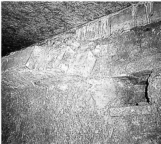
Mittelalterliche (?) Werkstücke (Spolien) aus der Kapelle im Brudertöbéli, gefunden 1995/96 im «Hobi-Keller» in Oberötschwil. – Gewölbeansatz im «Hobi-Keller» mit maschinell hergestellten Ziegeln; darunter zwei Balkenlöcher. – Fotos Kantonsarchäologie.
