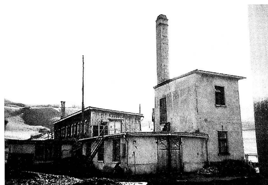
Die Gerberei auf der östlichen Seite (Aufnahme 1943), mit Häutelager links, dem alten Gerbeteil mit Holzaufbau in der Mitte, erbaut etwa 1880. Im Vordergrund links der Flachdachbau mit Gruben versehen und rechts anschliessend das Kesselhaus mit Dampfkessel und Oberbau, erstellt ca. 1911/12.
