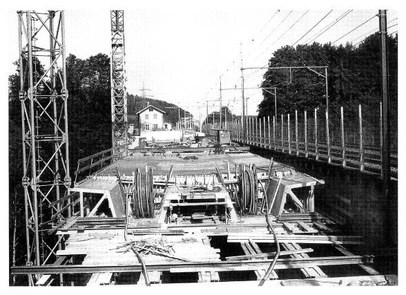
Während einiger Monate wird der Eisenbahnverkehr einspurig über das neue Viadukt in provisorischer Lage geführt. Nach dem Abbruch der Betonbrücke von 1927 und dem Bau der endgültigen Fundamente und Widerlager erfolgt der Verschub des ganzen Bauwerkes. In Zahlen: Das rund 6000 Tonnen schwere Glattviadukt wird in höchstens 9 Stunden um 10,25 Meter querverschoben.
