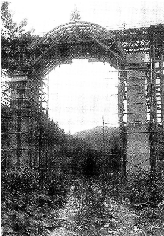
Der mittlere Lehrbogen ist auf den neuen Brückenpfeilern aus Beton aufgebaut und trägt das obligate Aufrichtebäumchen. – Sammlung: K. Anderegg, Flawil.
