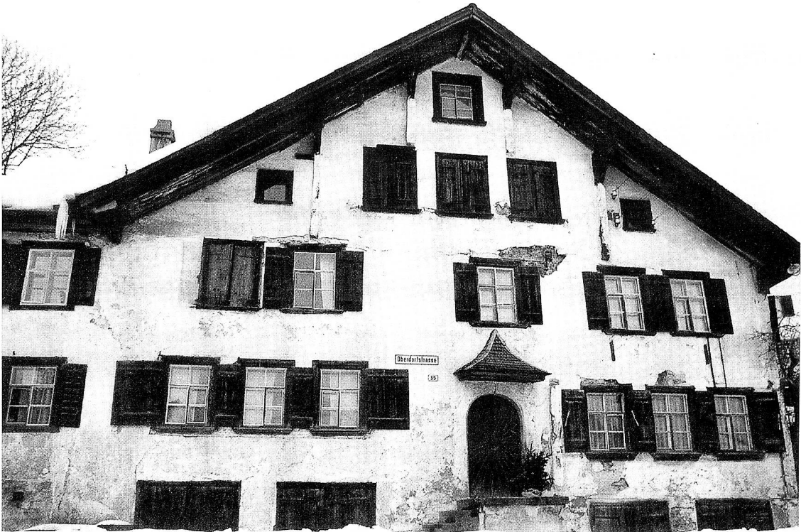
Ebnat-Kappel, Ackerhusweg 26 (ehemals Oberdorfstrasse 35). Giebelfront mit einheitlichem Putzkleid des 19. Jahrhunderts. Die «springenden» Fenster und Unebenheiten lassen die bewegte Baugeschichte erahnen. – Foto Heini Oberli, Wattwil.
