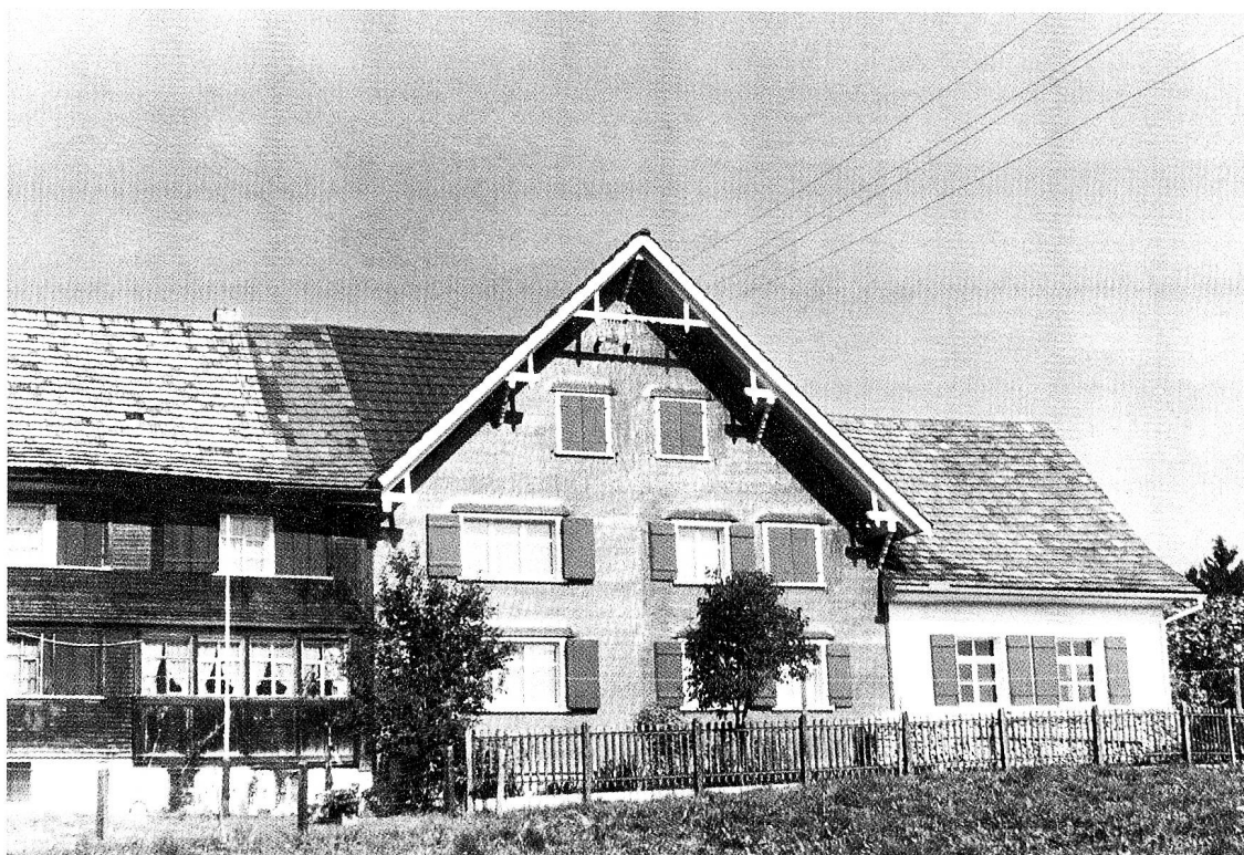
Bauernhaus des 18. Jahrhunderts, im 19. Jahrhundert durch Wohnlokal und um 1900 durch Stickerlokal erweitert. Stickereiliegenschaft Josef Rüttsche, Rimensberg/Lütisburg.
