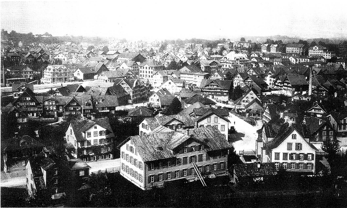
Flawil, altes Dorfzentrum mit Gupfenquartier, um 1900. Im Vordergrund Degersheimerstrasse mit Fabrikgebäuden Lüthi und Steiger sowie Stickerei Hartmann. Rechts oben Stickerei Naef, im Mittelgrund neues Gemeindehaus in Bau (heute Bezirksgebäude). – Foto Zentralbibliothek Zürich, Graphische Sammlung.
