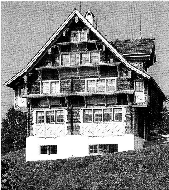
Das 1987 von Kappel nach Bächli, Hemberg, versetzte Haus mit neuen Klebedächern und Zielerementen.
