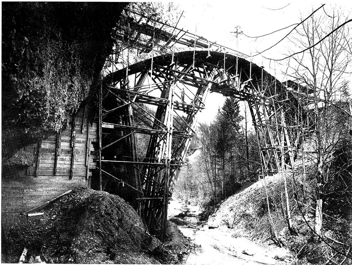
Libingen. Lehrgerüst der Brücke über das Mühltobel im Frühjahr 1917. – Foto Albert Lichtensteiger,
