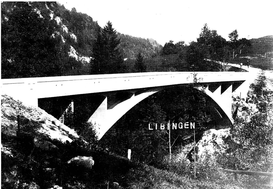
Betonbogenbrücke mit Fachwerk über das Mühltobel kurz nach Fertigstellung 1917.
