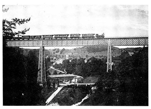
Die drei Brücken bei Lütisburg: die Holzbrücke über die Thur, erbaut 1778; die Steinbogenbrücke über den Gonzenbach, um 1830; die Eisengitterbrücke über das Gonzenbachtobel, erbaut 1868/69durch die Firma Wieland, Gubser & Co., abgebrochen und ersetzt 1945. Fotografie um 1900.
