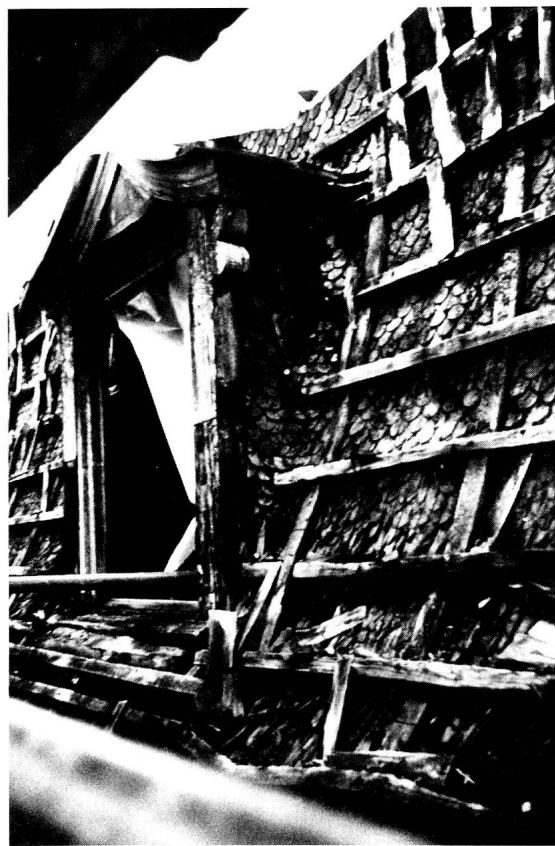
Alte Rundschildelbedachung nach Entfernung der Ziegeldeckung im Bereich einer Lukarne. – Foto Walter Scheiwiller, Ebnet-Kappel.
